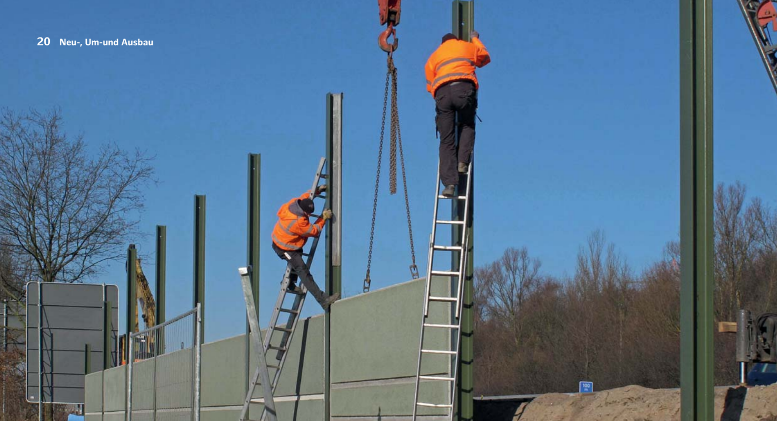
Hier erfolgt gerade das Einhängen von Wandelementen des ergänzenden Lärmschutzes an der A25 zwischen der AS HH-Nettelburg und HH-Bergedorf.
