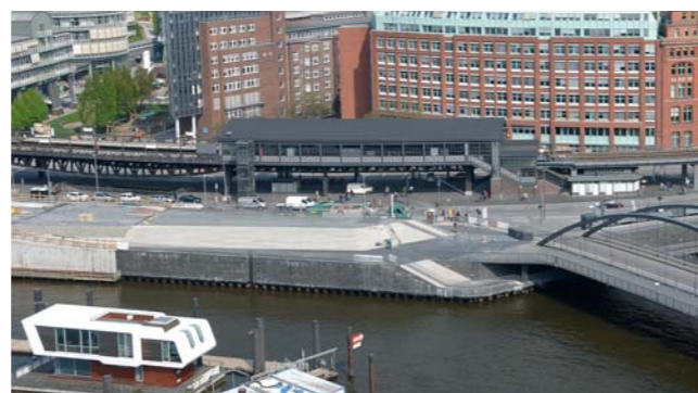
Für die zur Wasser- als auch Landseite gerichteten Treppen und Rampen wurden vom LSBG speziell angefertigte Treppenfertigteile verlegt.
