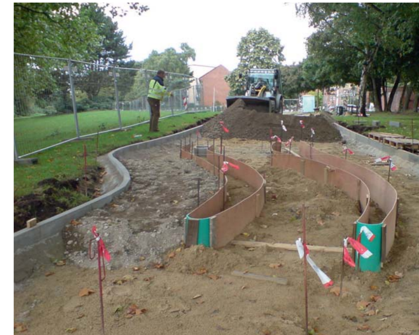
Eine 2,8 km lange Teilstrecke der Veloroute 8 konnte der LSBG im Jahr 2013 fertigstellen.
