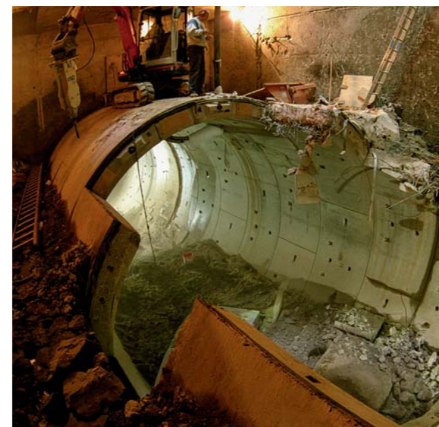
Spezialtiefbau auf engstem Raum: Zwischen Dezember 2004 und Sommer 2006 wurden auf einer Länge von 1.750 m zwei parallel laufende, jeweils einleisige kreisförmige Tunnel hergestellt.
