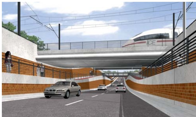
Das Trogbauwerk führt Straße und Gehweg unter der Bahnstrecke durch.
