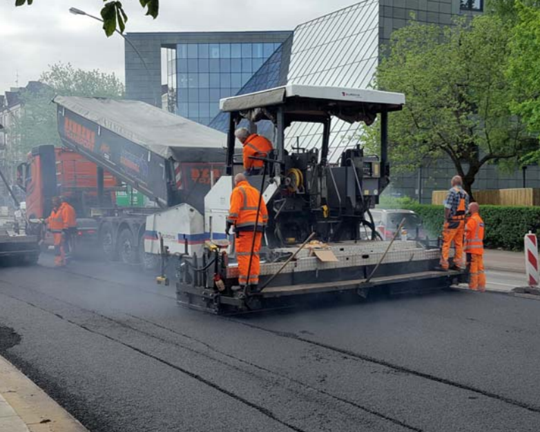
Arbeiten in der Stresemannstraße, Ecke Ruhrstraße.
